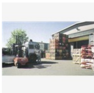
Trattasi del carico e scarico dei materiali nell'ambito del cantiere
